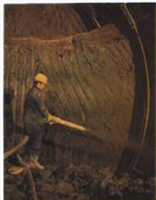
写真-1 フランクフルト地下鉄工事現場での吹付コンクリート作業
